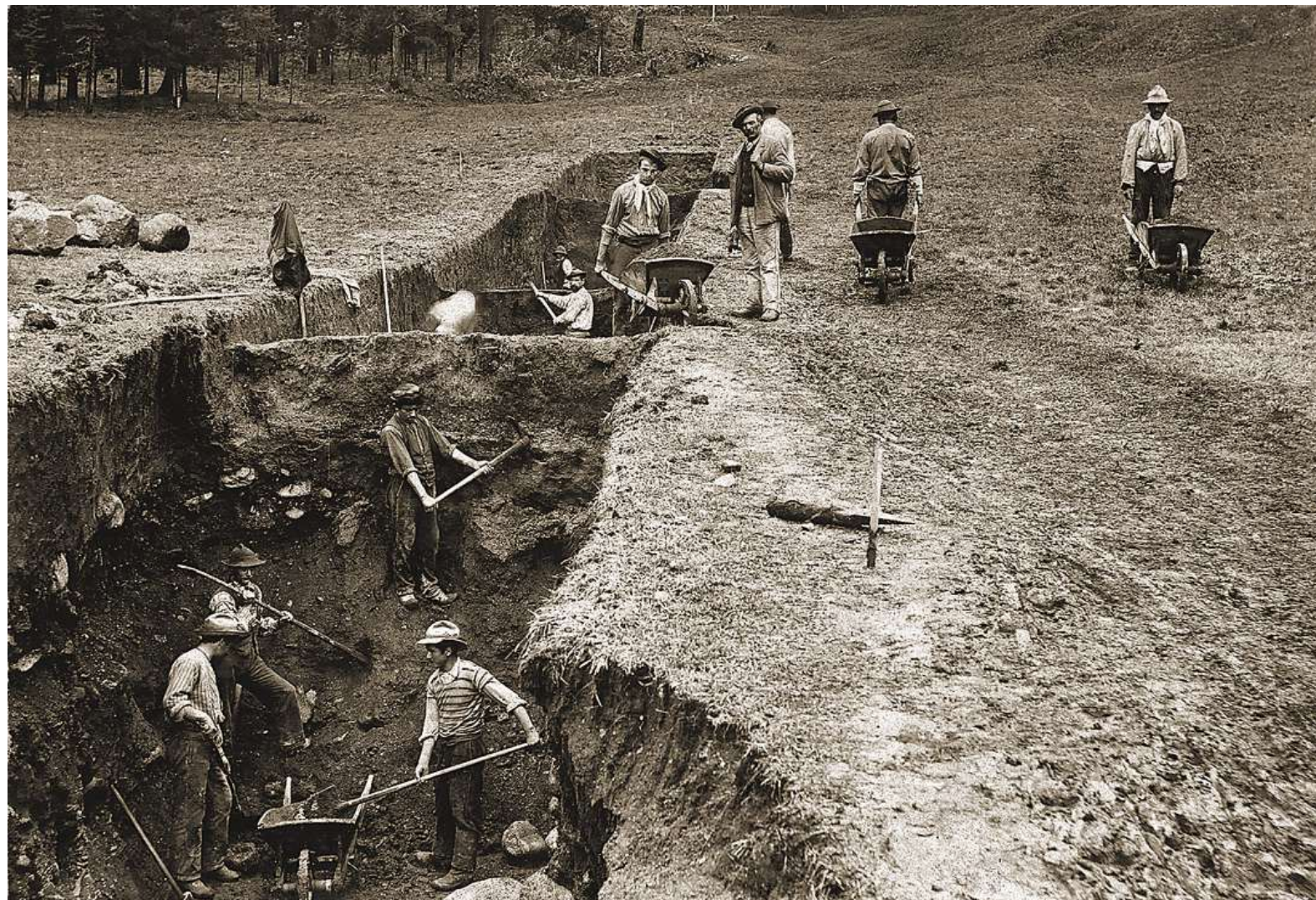
Mit Schaufel und Schubkarre: In der Val Bever wird die Bahnstrecke zum künftigen Albulatunnel ausgehoben. (ARCHIV RHB)
